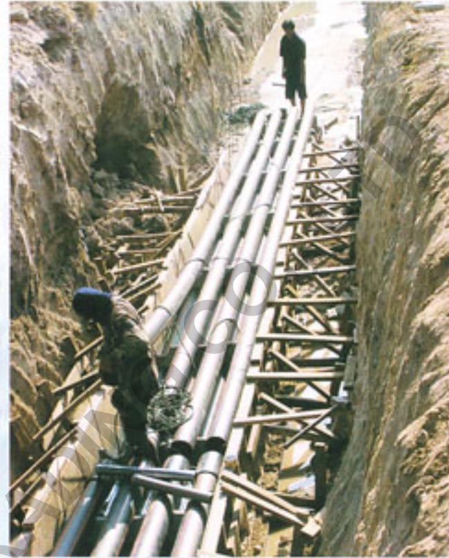
ใช้ในงานท่อร้อยสายไฟฟ้า สายเคเบิล (Conduit System)
