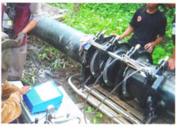
ควบคุมคุณภาพงานเชื่อมด้วย TGG WIZDOM DATA LOGGER สามารถควบคุมให้งานเชื่อมสมบูรณ์ 100% และเป็นไปตามมาตรฐาน DVS - 2207
