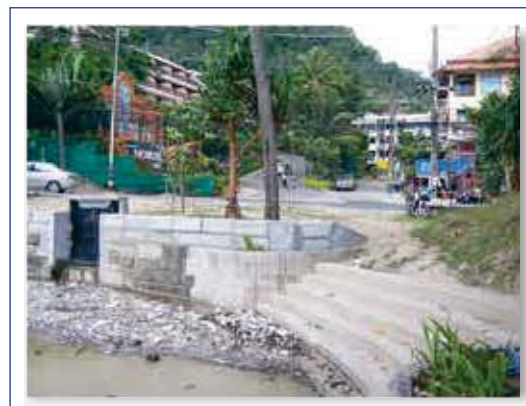
วางท่อระบายน้ำ ลงสู่ทะเลเสร็จเรียบร้อย ปลายท่อนมีประตูเปิด - ปิด กันน้ำทะเลไหลเข้าเมื่อน้ำขึ้น
