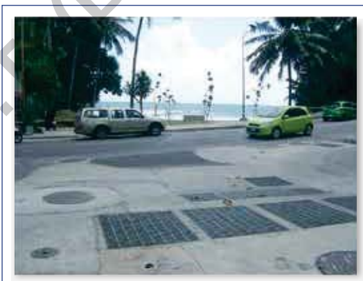
วางท่อเสร็จ ปิดผิวถนนพร้อมใช้งาน (ท่อ PROPIPE สามารถรับแรงกดทับ) ได้ถึง 10 ตัน/ม 2 จึงไม่มีปัญหาเรื่องถนนยุบหรือท่อหักกลางเนื่องจากดินทรุดตัว)
