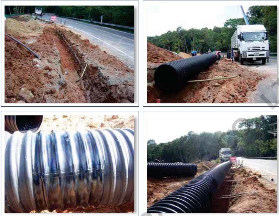
➡ โครงการวางท่อระบายน้ำตำบลภูฝักราชนิเวศน์ จังหวัดเชียงใหม่
