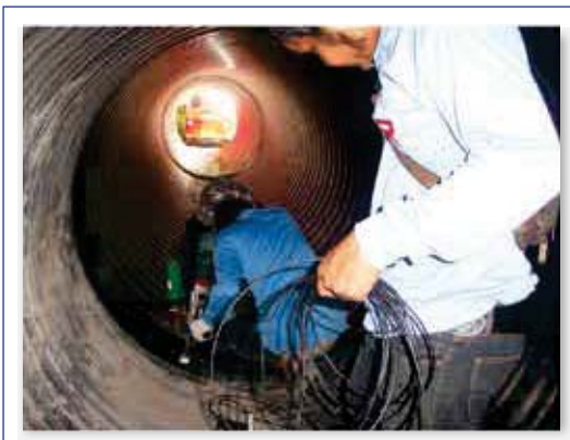
เชื่อมต่อภายนอกด้วยลวดพีอี ระบบร้อน ไม่มีการรั่วซึม
